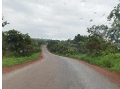
Photos 33:PK26 et PK38+700-Succession de rayons nécessitant une amélioration du tracé
