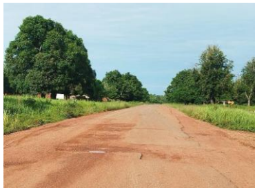
Photos 17: PK152 et PK175-arrachement d'une partie de la couche de surface
