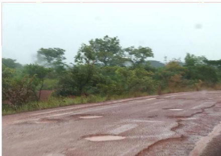
Photos 12: PK53, nids de poule de grande profondeur et de faible surface mais en nombre
