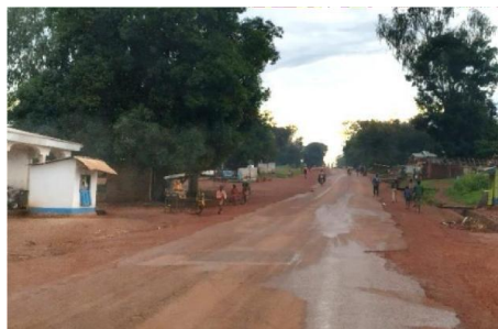
Photos 10: PK65.6-entrée de Yaloké chaussée
