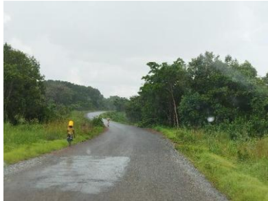
Photos 33:PK26 et PK38+700-Succession de rayons nécessitant une amélioration du tracé
