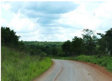
Photos 33:PK26 et PK38+700-Succession de rayons nécessitant une amélioration du tracé
