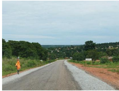
Photos 30:PK225-rechargement des accotements
