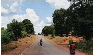
Photos 45: Fossés trapézoïdaux bétonnés et en
