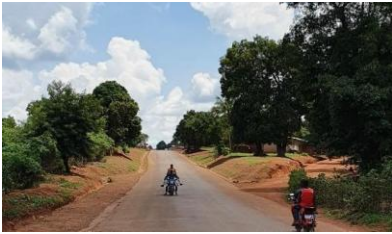
Photos 45: Fossés trapézoïdaux bétonnés et en
