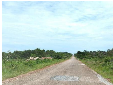
Photos 28:PK216-nids de poule récemment réparés d'eau
